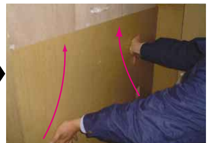
壁下地に下から押し付けて固定
