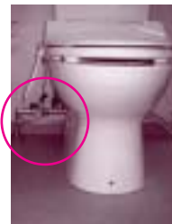
便器に向かって 左側
