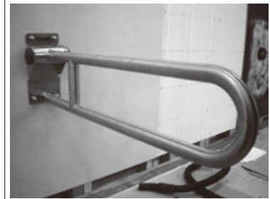
手すり取り付け
