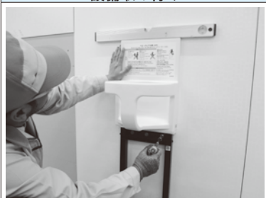
設備取り付け
