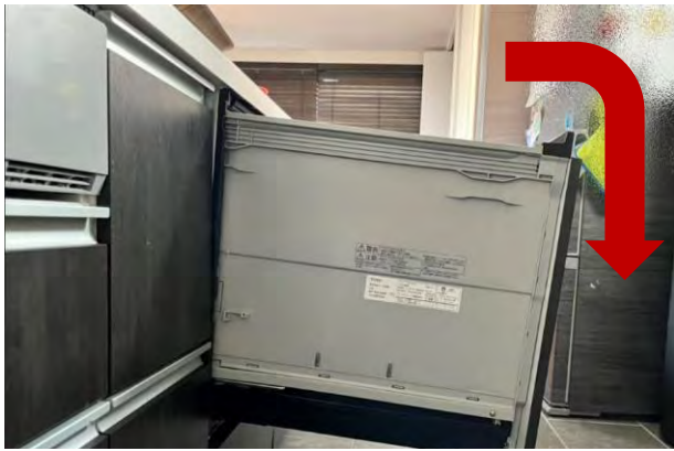
タンクが下がっている
