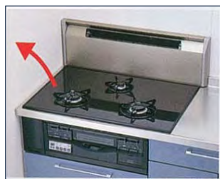
既設コンロを引き上げます
