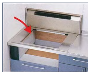
コンロ取替アダプターを設置します
