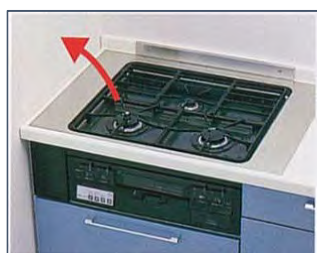
既設コンロを引き上げます
