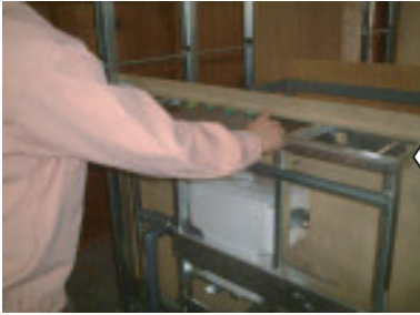
床調整ボルトを回して水平が出る ように調整します。
