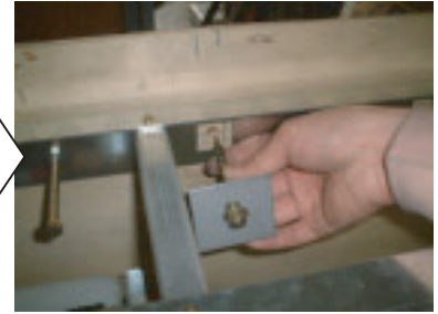
ケーシングの角穴を通し、壁固定 アンカーに接合します。
