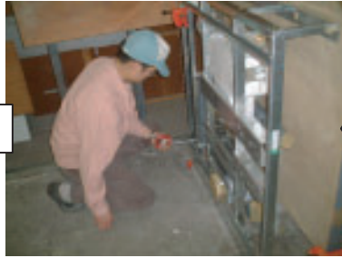
壁調整ボルトを回して倒れない ように調整し、
