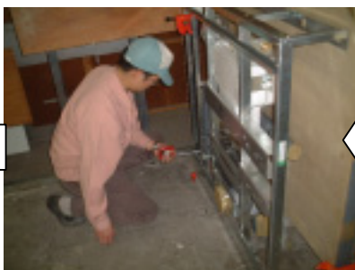
壁調整ボルトを回して倒れないよ うに調整し、
