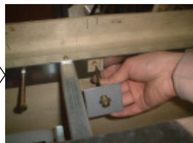
ケーシングの角穴を通し、壁固定 アンカーに接合します。
