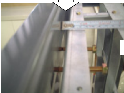
壁とケーシングとの隙間は 10mm が基本となりますが、 壁の倒れに応じ調整ください。
