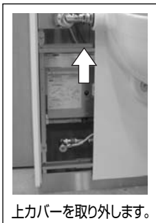
フラッシュバルブ用、電気温水器用前板を取り外します。
